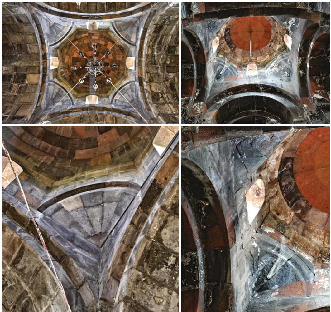
16/ Gli elementi geometrici fondamentali nella trasformazione di un pennacchio a tromba nella volta conica della Cappella Palatina (elaborazione di Carlo Bianchini).
